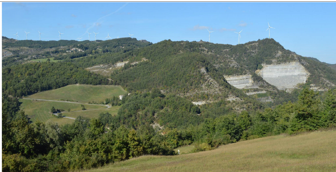
Foto 003 del 29/09/2014: panoramica del bacino estrattivo del Peglio ripresa dalla collina del Pago. Da sinistra le cave Sassicheto, Roncacci del Carpine, Forcone del Carpine. Più in lontananza l'abitato del Peglio e i parchi eolici.
