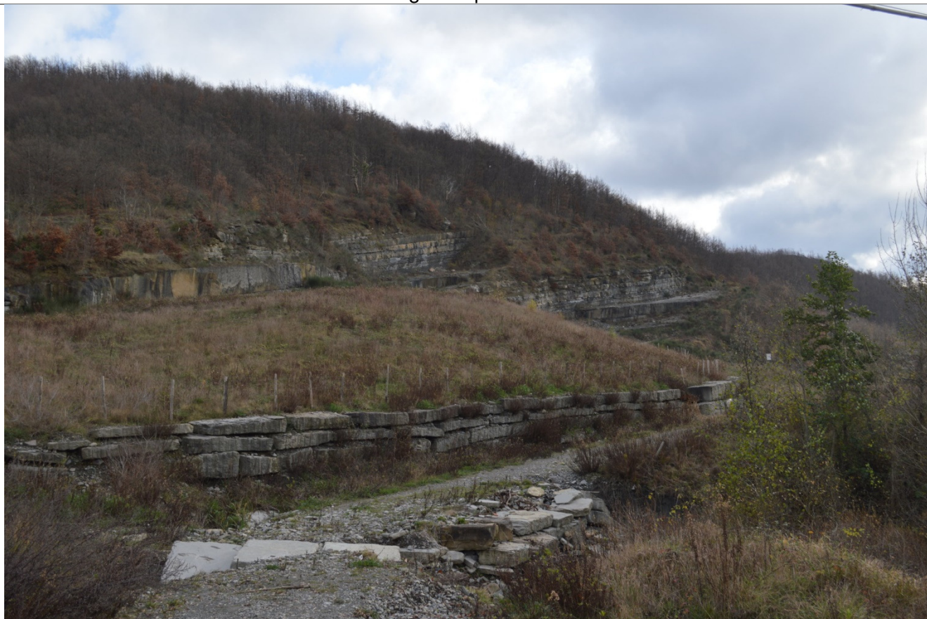
Foto 101 del 09/12/2014: cava Sassicheto vista dalla pista di accesso. In primo piano il settore ripristinato dalla ditta Sercecchi, sullo sfondo la zona d'intervento.
